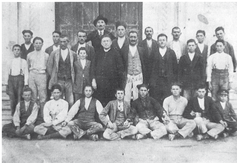
Don Brendolan in una foto ricordo assieme ai muratori dell'impresa Tognetto Patrizio (1876-1952) , impegnati nei lavori della chiesa. (agosto 1924)
